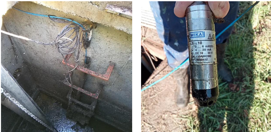
Figura 4. Vista xeral do bombeo (esquerda) e medidor de nivel hidrostático (dereita).
