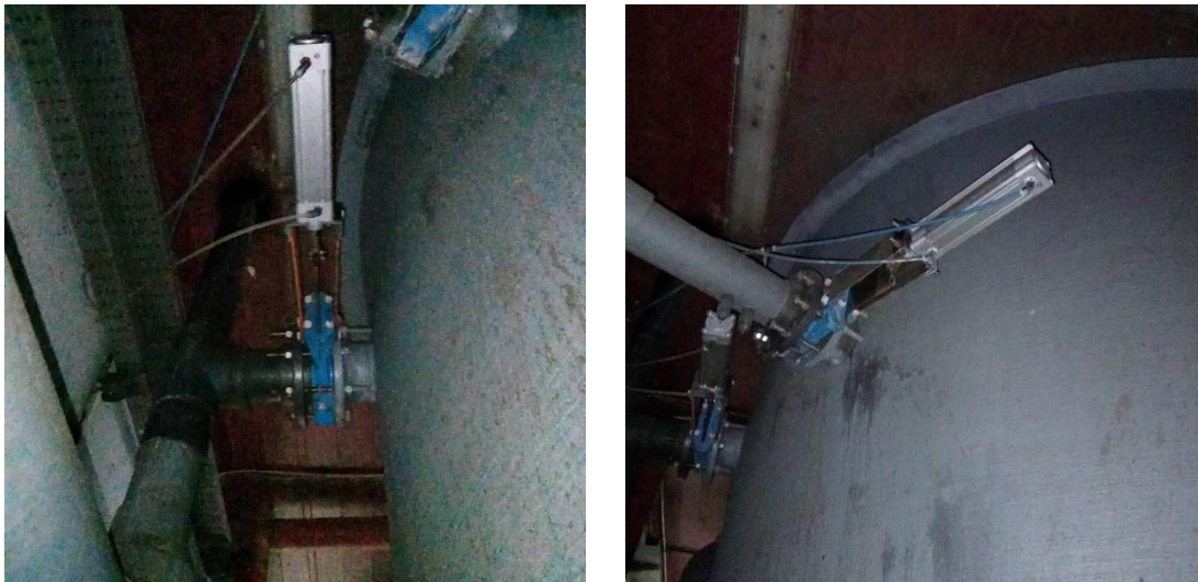
Figura 8. Válvula talladeira pneumática da liña 1 (esquerda) e válvula talladeira pneumática da liña 2 (dereita)
