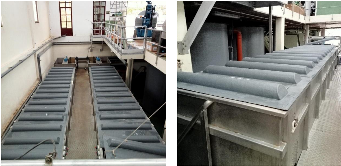
Figura 13. Vista xeral de varredoras de cadea-piñón con cuberta de sistema de desodorización.
