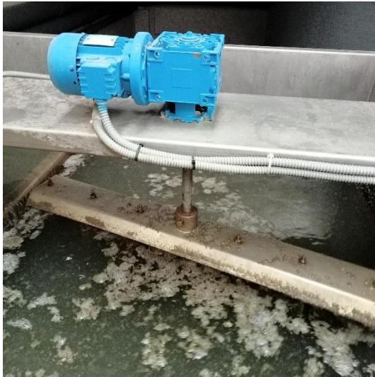
Figura 11. Axitador vertical da liña 1 (esquerda) e axitador vertical da liña 2 (dereita)
