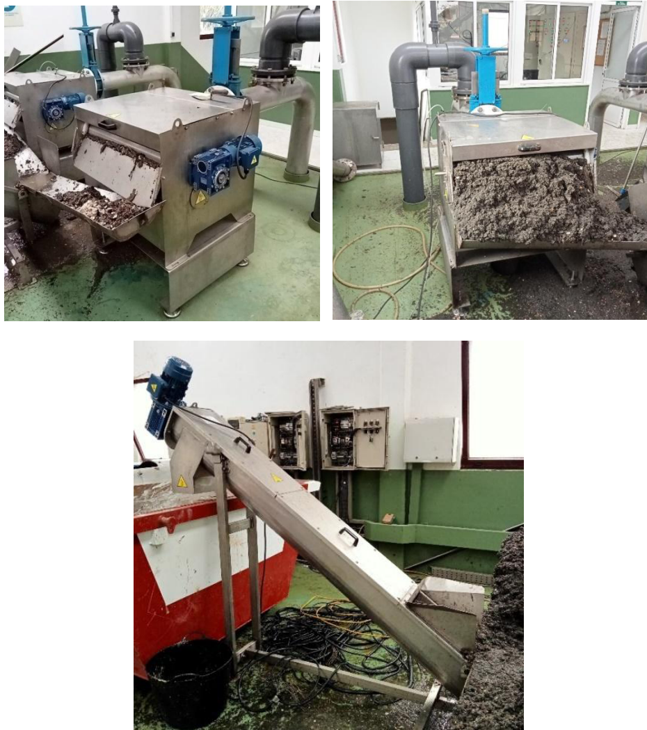
Figura 6 Rotocriba N°1 (superior esquerda), rotocriba N°2 (superior dereita) e parafuso compactador transportador (inferior)
