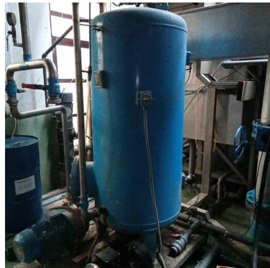
Figura 16. Calderín da liña 1 (esquerda) e calderín da liña 2 (dereita)
