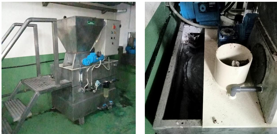
Figura 20. Vista xeral da estación de preparación de polielectrolito actual
