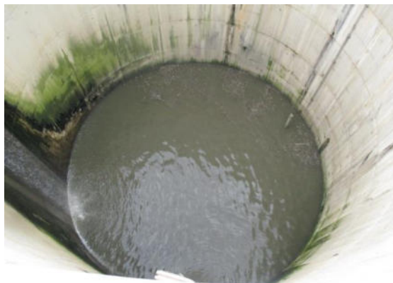
Figura 22 Vista da cámara de carga do emisario submarino.
