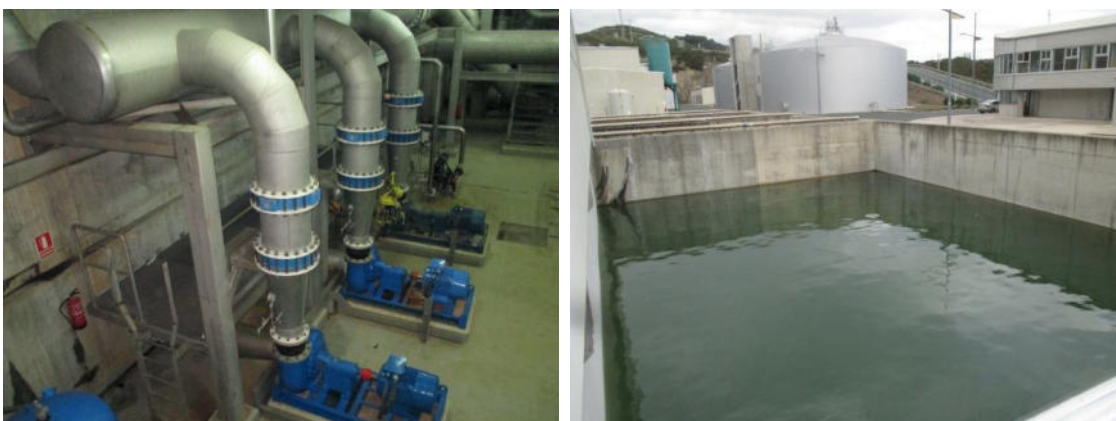
Figura 20 Bombas de lavado dos biofiltros (esquerda) e depósito de augas sucias procedentes do lavado dos biofiltros (dereita).
