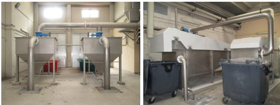
Figura 17 Clasificador de areas (esquerda) e concentrador de graxas (dereita).
