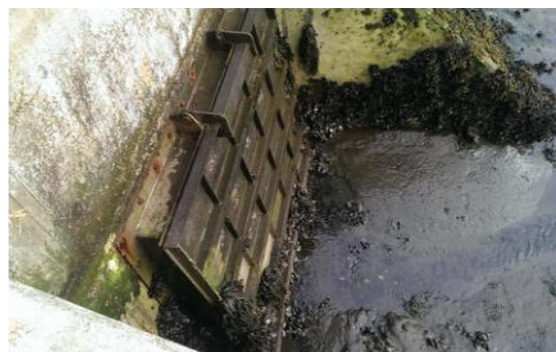
Figura 3 Comporta principal e comporta de alivio xeral.
