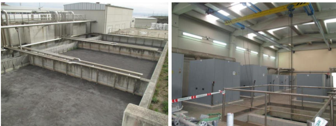
Figura 19 Biofiltros (esquerda) e soprantes do tratamento biolóxico (dereita).
