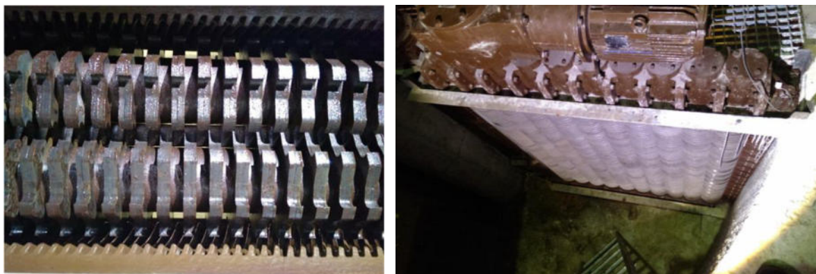
Figura 4 Trituradora de sólidos e Discreen.
