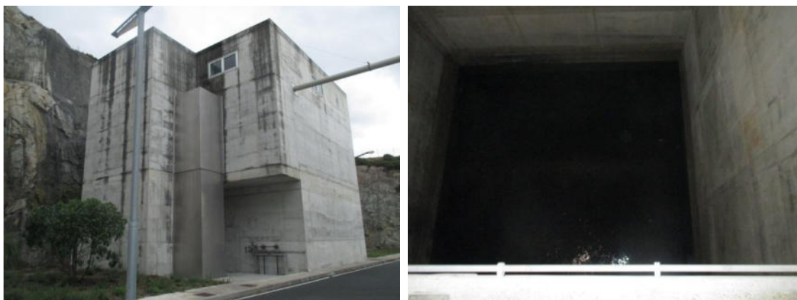
Figura 10 Edificación de obra de chegada (esquerda) e cámara de carga de obra de chegada (dereita).
