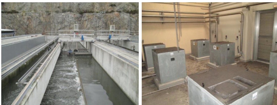
Figura 15 Desareador-desengraxador (esquerda) e soprantes do desareador-desengraxador (5+1) (dereita).
