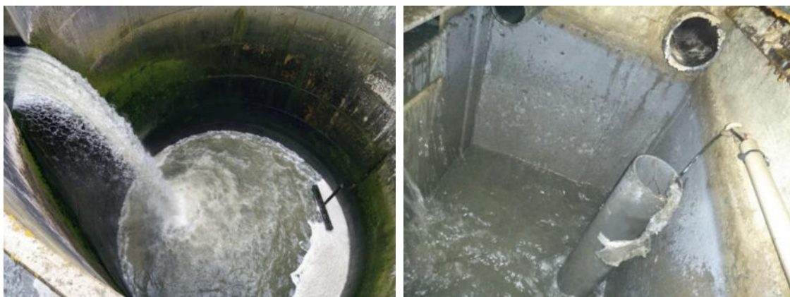
Figura 31 Cámara de carga do emisario (esquerda) e conducción de alivio (dereita).
