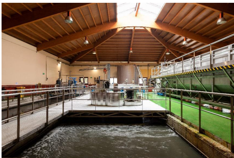
Figura 1 Vista xeral da EDAR de Ortigueira
