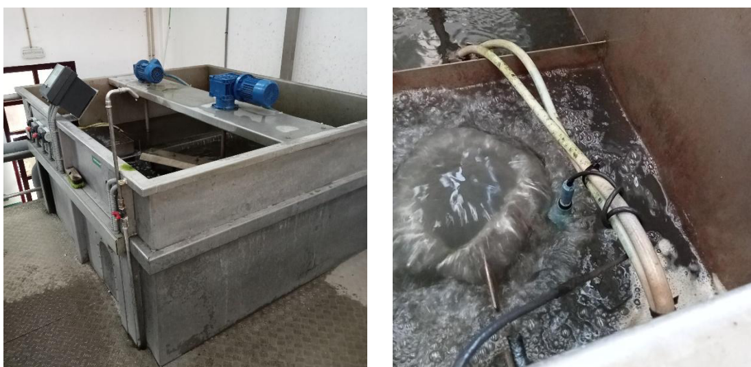
Figura 9 Cámara de coagulación-floculación (esquerda) e cámara de rotura coa sonda de pH dunha das dúas liñas de tratamento FQ (dereita)
