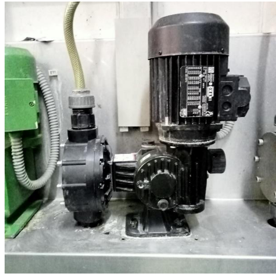
Figura 12. Bomba dosificadora de floculante da liña 1 (esquerda) e da liña 2 (dereita)
