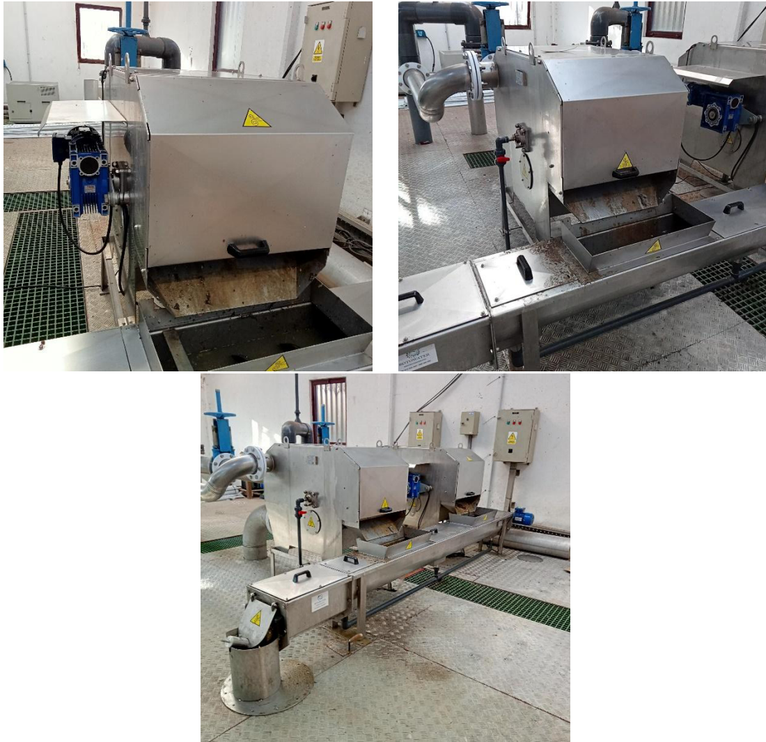
Figura 5 Grupo de pretratamento composto por dúas rotocribas (superior esquerda, liña 1 e superior dereita, liña 2) e un parafuso compactador (inferior)
