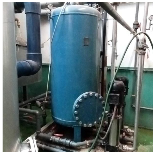
Figura 13. Compresor de pistón (esquerda) e calderín so sistema DAC (dereita)
