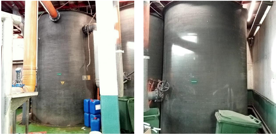
Figura 6. Depósito de homoxeneización da liña 1 (esquerda) e da liña 2 (dereita)
