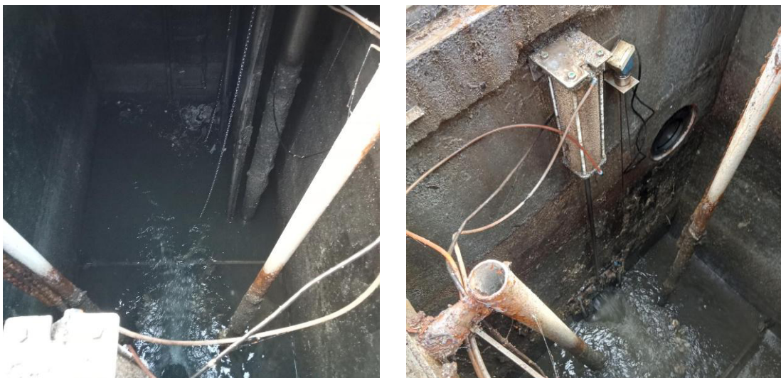
Figura 4. Guías do cestón de grosos, actuador pneumático da comporta de entrada ao pozo e aliviadoiro no pozo de bombeo
