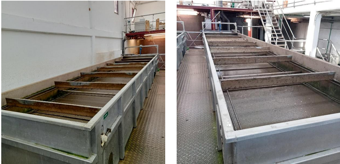
Figura 10. Varredora cadea-piñón da liña 1 (esquerda) e varredora cadea-piñón da liña 2 (dereita)
