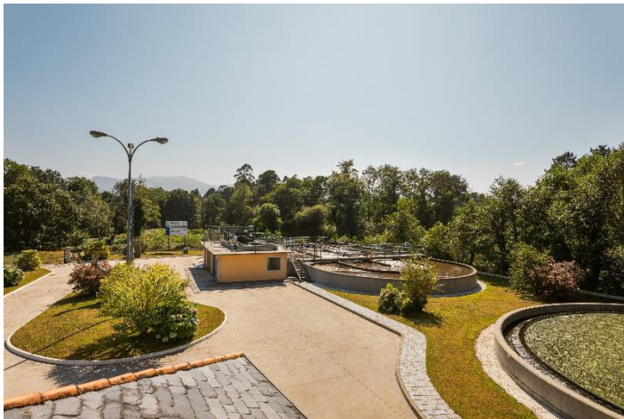
Figura 1. Vista xeral da EDAR de Alfoz-Valadouro
