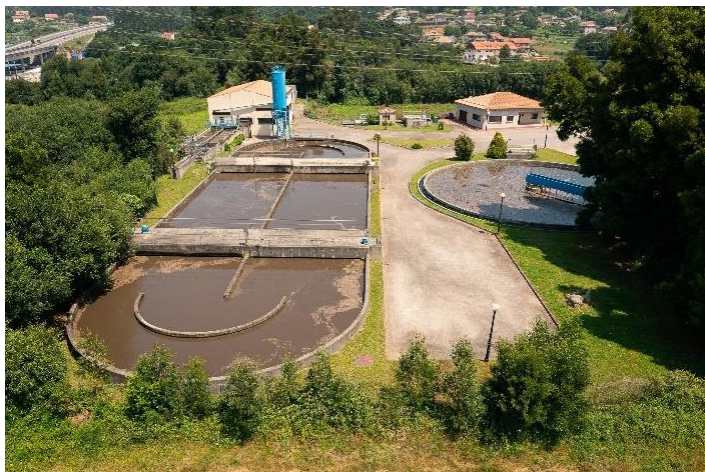
Figura 1. Vista xeral da EDAR de Gondomar
