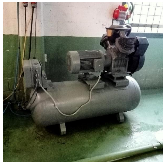
Figura 15. Calderín (imaxe superior) e compresores de pistón (imaxes inferiores)
