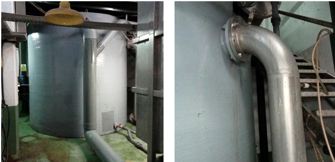
Figura 10. Vista xeral do depósito de homoxeneización (esquerda) e saída cara a liña de flotación (dereita)
