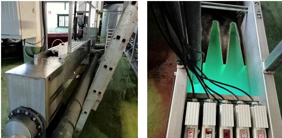
Figura 16. Vista xeral da desinfección (esquerda) e detalle bancadas (dereita)
