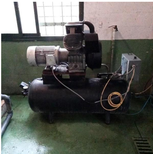
Figura 15. Calderín (imaxe superior) e compresores de pistón (imaxes inferiores)
